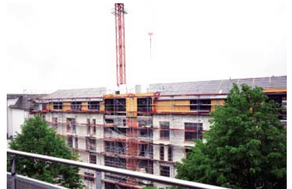
Bilder: Baustelle Neubau Gustav-Schulenburg-Str.
