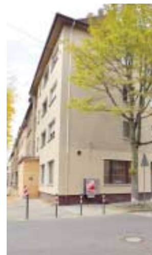
Bilder oben und unten: Derzeit im Bau: unsere neue Geschäftsstelle
